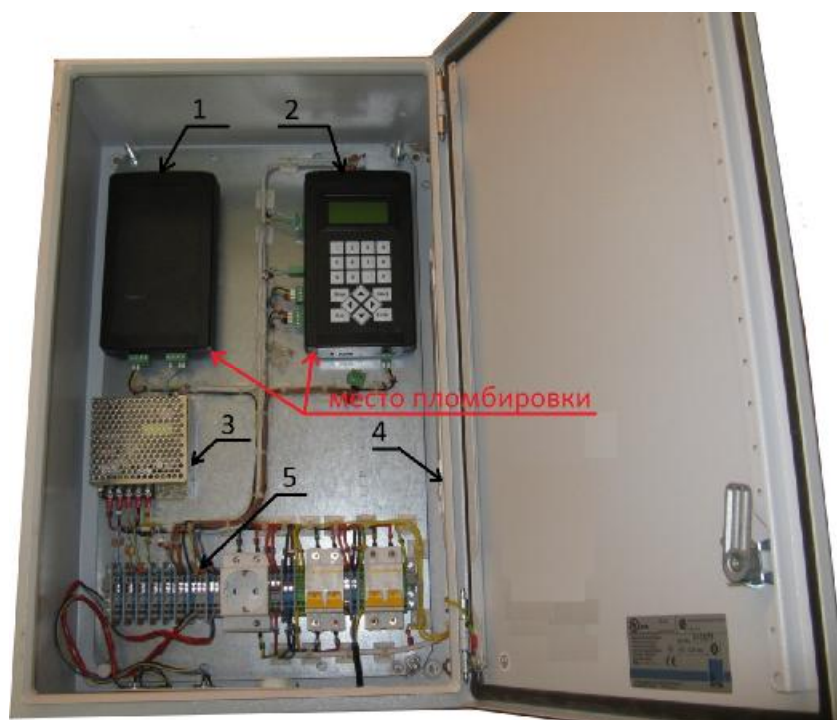
Рисунок 1 – Внешний вид блока измерительного ИС-14 1 – вычислитель; 2 – контроллер ИС-14; 3 – источник питания; 4 – лампа освещения; 5 – клеммная колодка.
